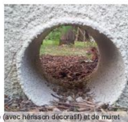
Aménagements d'ouvertures en pied de clôture (avec haïrison décoratif) et de muret
