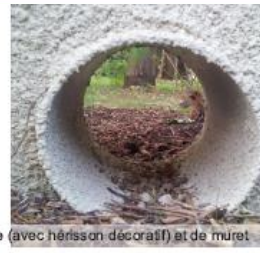
Aménagements d'ouvertures en pied de clôture (avec hérisson décoratif) et de muret
